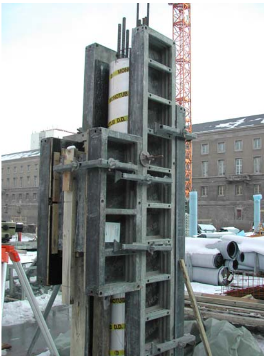
Abbildung 32 Rundstütze mit Konsolausbildung
