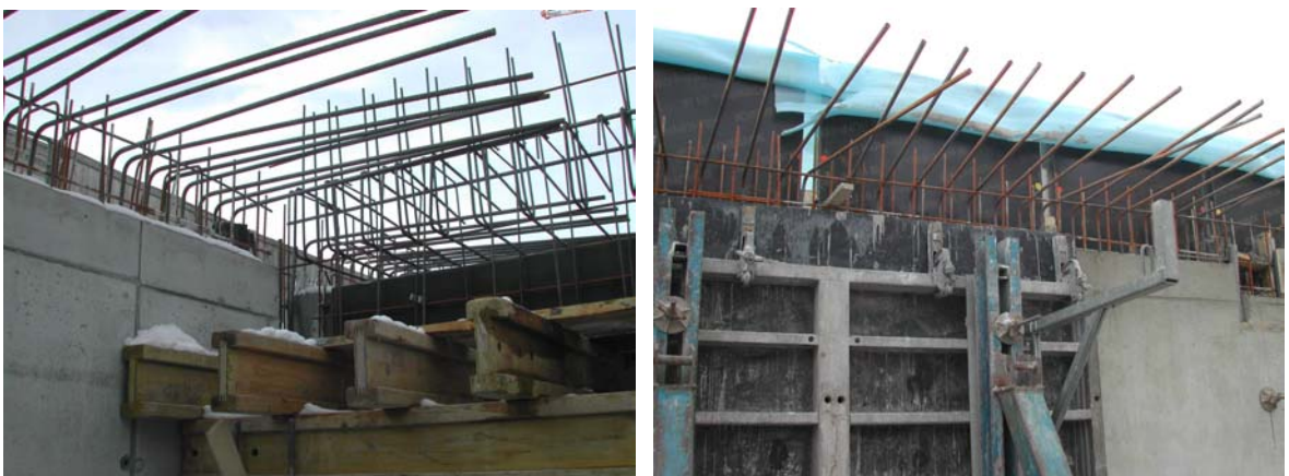
Abbildung 35 Anschlussbewehrung
