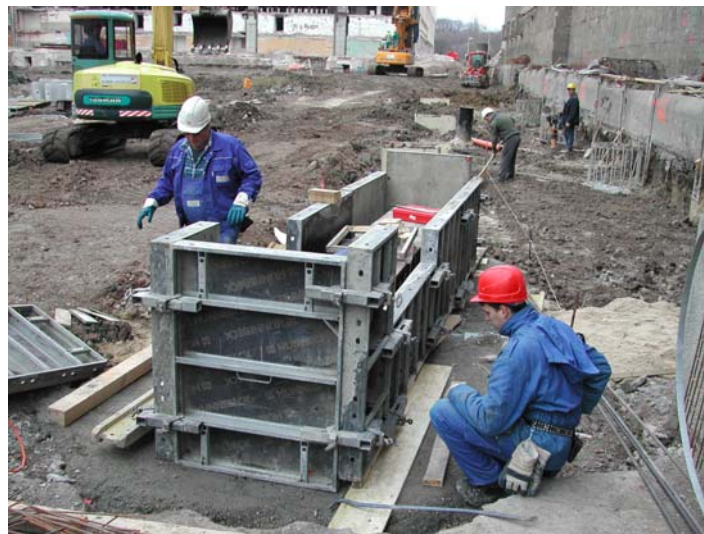
Abbildung 40 zusammengesetzte Universalschalung
