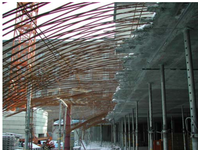
Abbildung 28 Anschlussbewehrung am Betonierabschnitt eines Deckenfeldes
