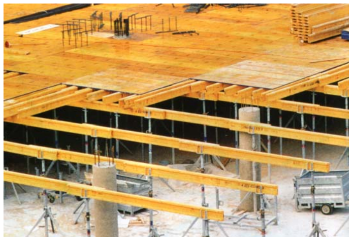
Abbildung 8 konventionelle Schalung (Dokaflex 1-2-4; Katalog Doka)
