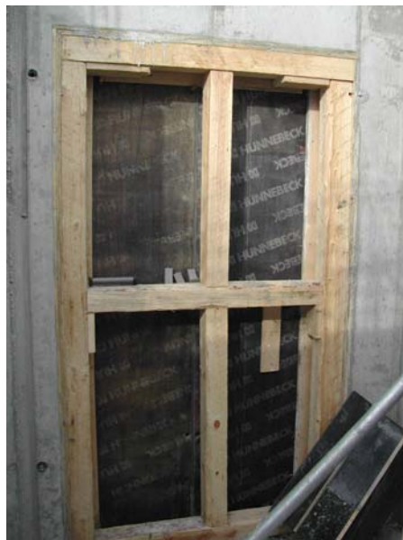
Abbildung 44 Holz- Aussparungsschalung
