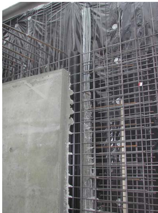
Abbildung 25 Anschlussbewehrung in Decke
