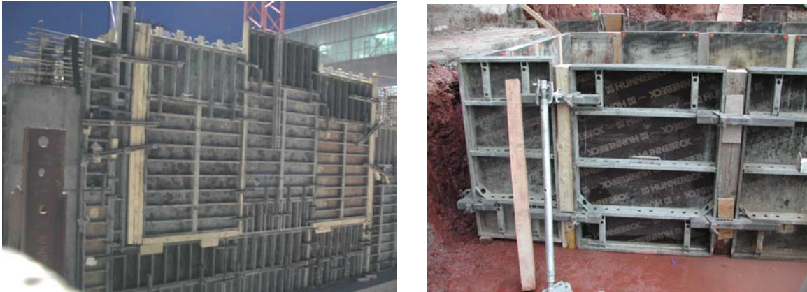
Abbildung 29 Pastsstreifen zum Schalungssystem
