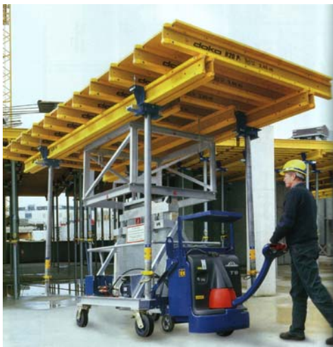
Abbildung 11 Dokaflex-Tische mit Verfahrwagen und Umsetzgabel ; Doka Katalog
