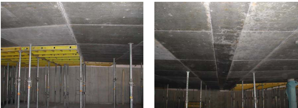
Abbildung 33 Ausbildung von Deckengefälle
