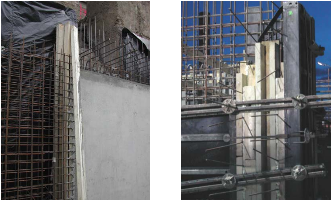
Abbildung 27 Anschlussbewehrung am Betonierabschnitt / Wandanschluss
