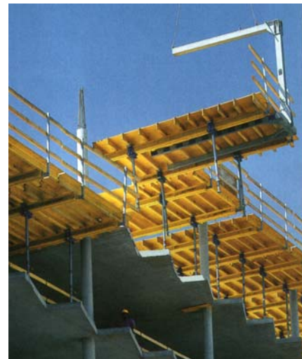
Abbildung 11 Dokaflex-Tische mit Verfahrwagen und Umsetzgabel ; Doka Katalog
