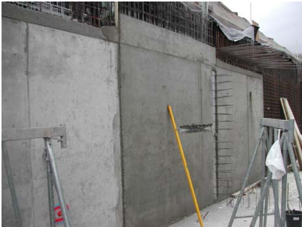
Abbildung 38 Bewehrungsrückbiegeanschlüsse aufgebogen in Praxis und Schema (Hal-fen-Katalog)
