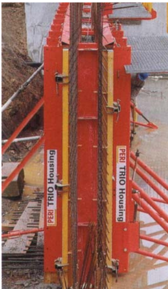
Abbildung 39 TRIO Abschalelement MT/MTF Peri, Werksunterlagen
