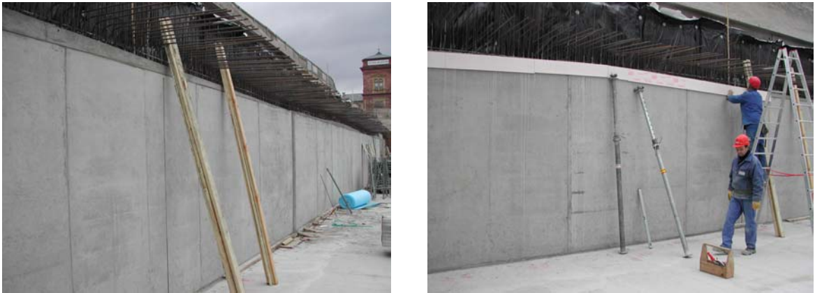
Abbildung 31 Schräger Anschluss Wand-Decke mit Ausgleichsbrettern
