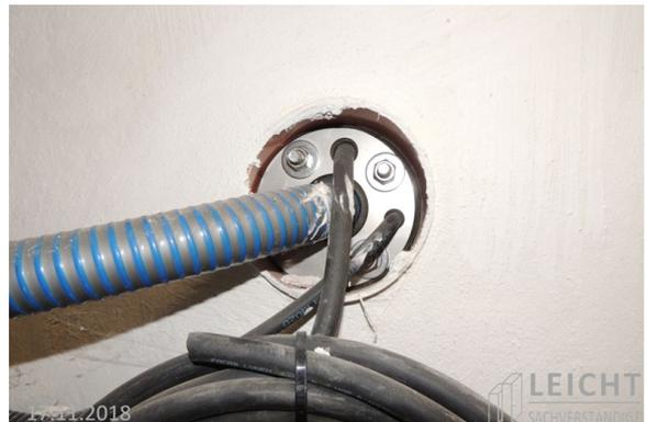
Abbildung 9: Einbaubeispiel Ringraumdichtung
