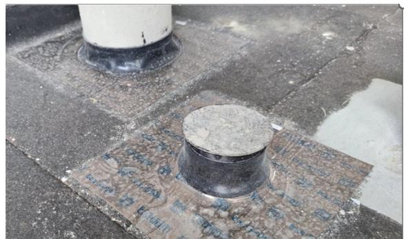
Abbildung 10: Einbaubeispiele Dichtmanschetten
