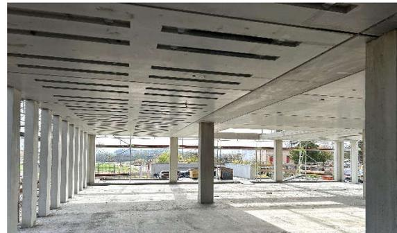
Abbildung 2: Deckenunterseite mit den Aussparungen für die Akustikabsorber
