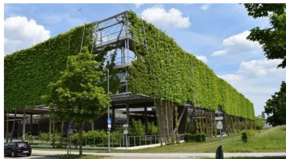
*Abbildung 1: Bodengebundener Bewuchs an Kletterhilfen (Swiss Re Bürogebäude München);
