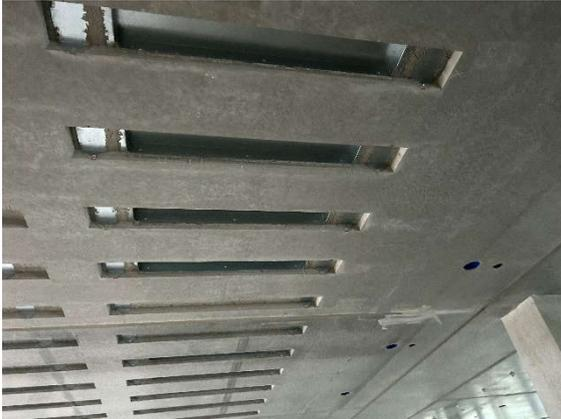
Abbildung 3: Aussparung für einen Absorber mit den ergänzten Volumen für die Tiefenabsorber
