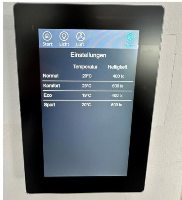
Abbildung 3: Bediendisplay mit Modi und einstellbarer Parameter
