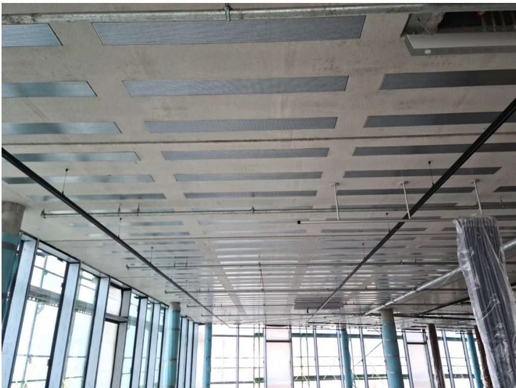
Abbildung 6: Deckenunterseite mit der Anordnung der Absorber
