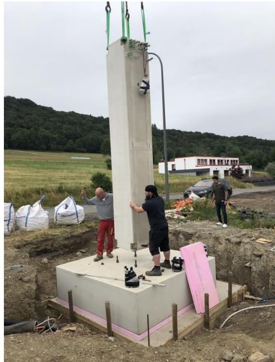
Abbildung 6: Montage der Energiesäule mit den vorgefertigten Elementen für das Fundament und den Turm
