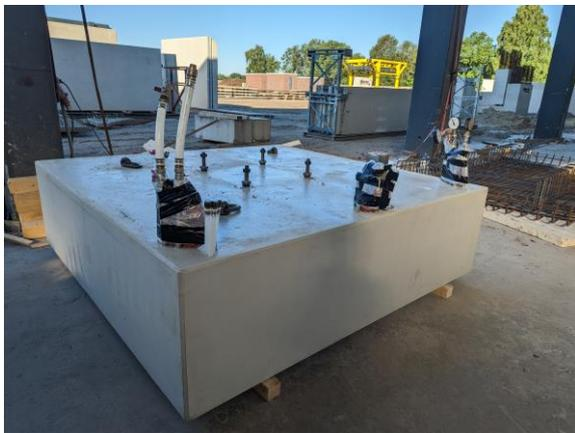
Abbildung 5 Vorgefertigter Fundamentblock für die Energiesäule
