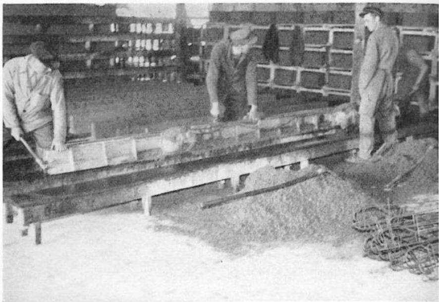
Im Betonwerk Heringen werden Deckenträger hergestellt
