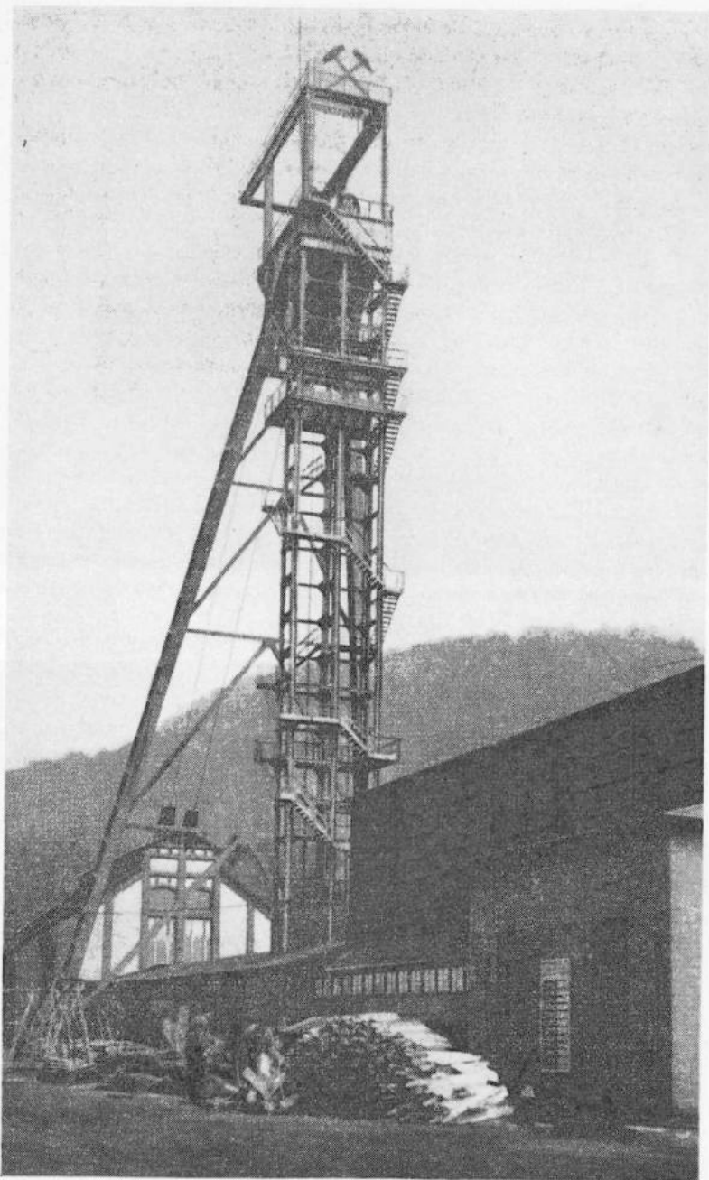
Förderturm des VEB Kaliwerk „Karl Marx“ in Sollstedt
