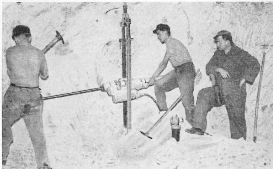
Im Kaliwerk: Bohrarbeiten „vor Ort“
