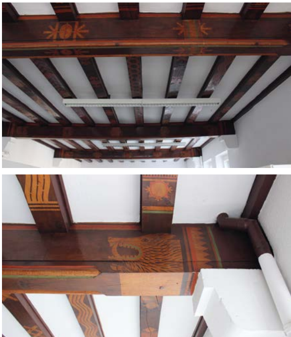
Abb. 1: Deckengestaltung in der ehemaligen Kantine, Bilder: Ivana Buhl.
