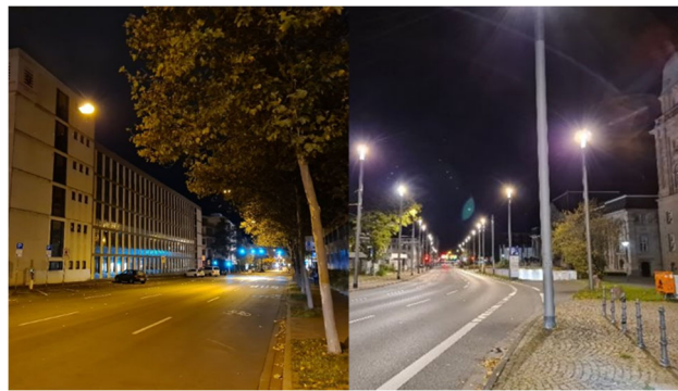
Abbildung 4: Der städtische Verkehrsraum bietet aufgrund der vorhandenen Straßenbeleuchtung ein großes Potenzial zur Effizienzsteigerung
