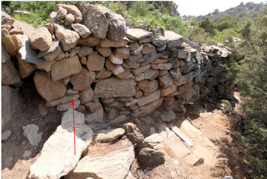
Abb. 37: Fundort Patitiria (20). Die Nord-Süd ziehende Mauer bindet an die nach West abknickende Feldmauer ein. Entlang dieser verläuft eine wahrscheinlich antike, gemauerte Treppe.
