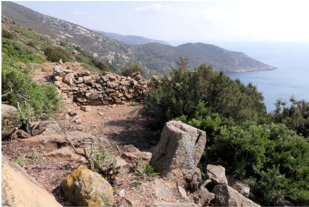
Abb. 36: Fundort Patitiria (20). Im linken Bildbereich verläuft die antike Mauerkonstruktion von Nord nach Süd bis an den hellenistischen Rundturm.
