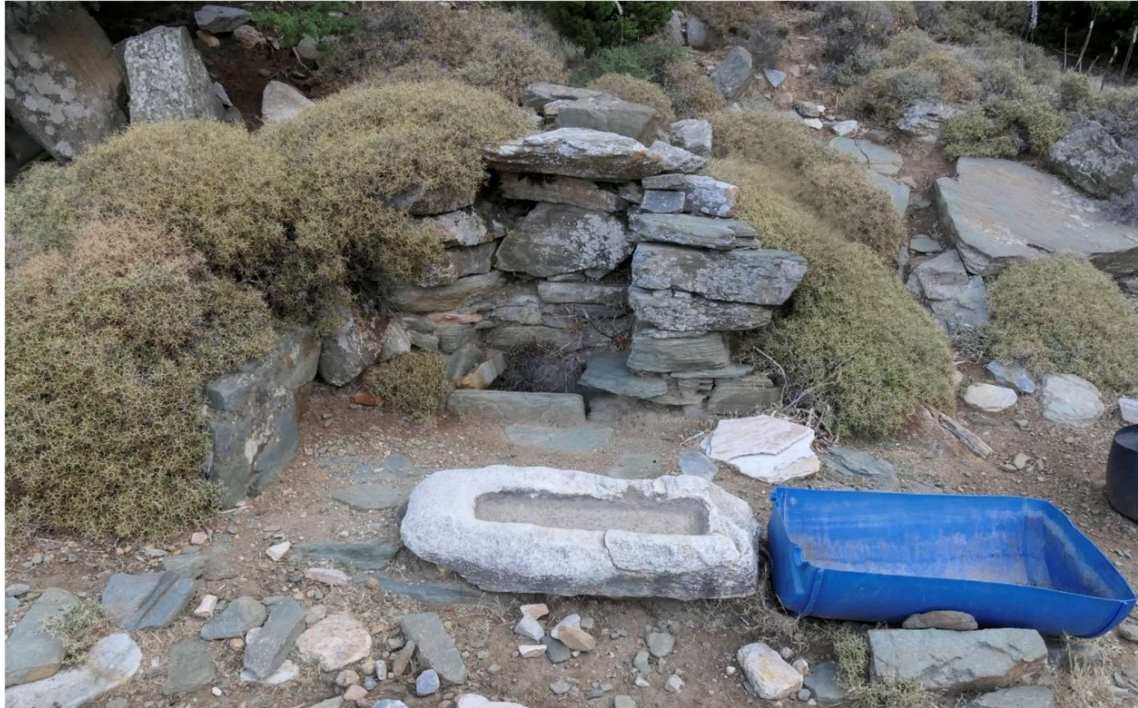
Abb. 22: Abgemauerter Quellaustritt nördlich von Agia Marina.
