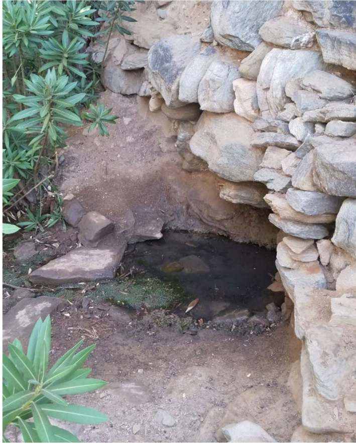
Abb. 23: Abgemauerter Quellaustritt unterhalb der Panagia Toso Nero.
