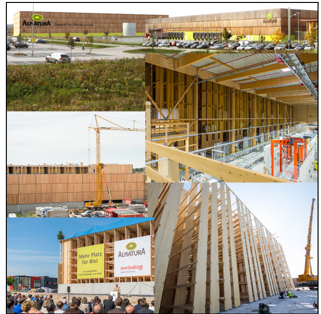
Abb. 41: Das Holz-Hochregallager der Alnatura Produktions- und Handels GmbH .
