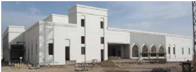
Abb. 1: Das im Bau befindliche Gebäude
