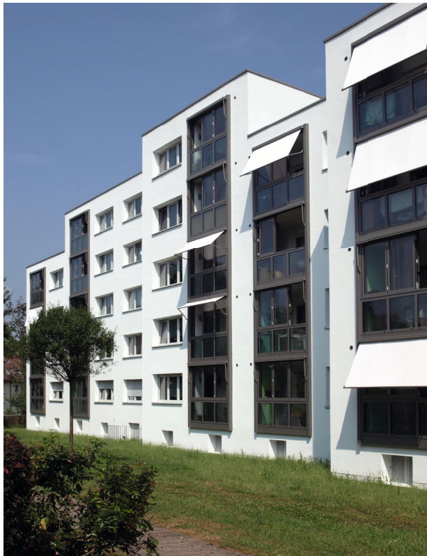
Abb. 9: Quellhofstraße 63 in Kassel (Foto: ISP 2013)
