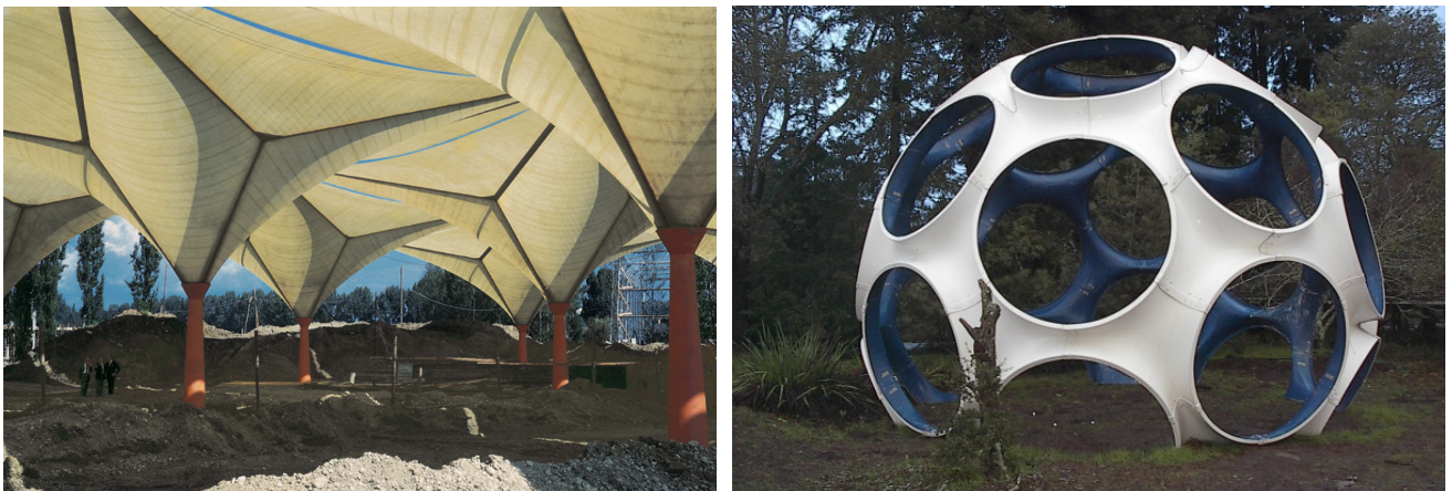
Abb. 2.2: links: GFK-Dach „Les Echanges“ mit Schirmen aus zusammengesetzten HP-Schalen zur Expo´64 Lausanne, HOSSDORF [20]; rechts: Fly´s Eye nach FULLER mit d=3,66 m, Sebastopol 2002, Quelle: www.bfi.org
