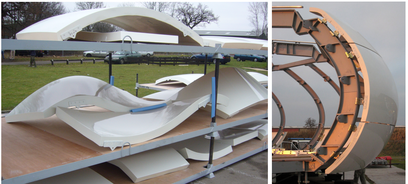
Abb. 3.10: links: GFK-Module mit geklebten und schraubengesicherten Verbindungsblechen auf Paletten für Containertransport, rechts: Verbindung der GFK-Module mit der Primärtragstruktur, Quelle: BORSTELMANN, ZAHA HADID ARCHITECTS, London
