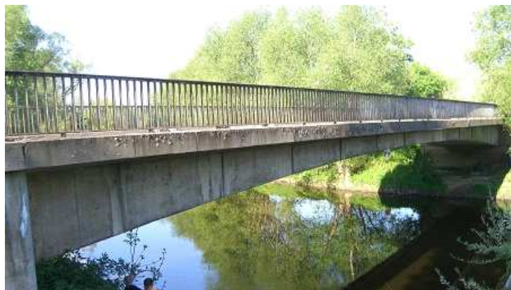
Abbildung 27: Brücke über die Saale bei Jena-Kunitz
