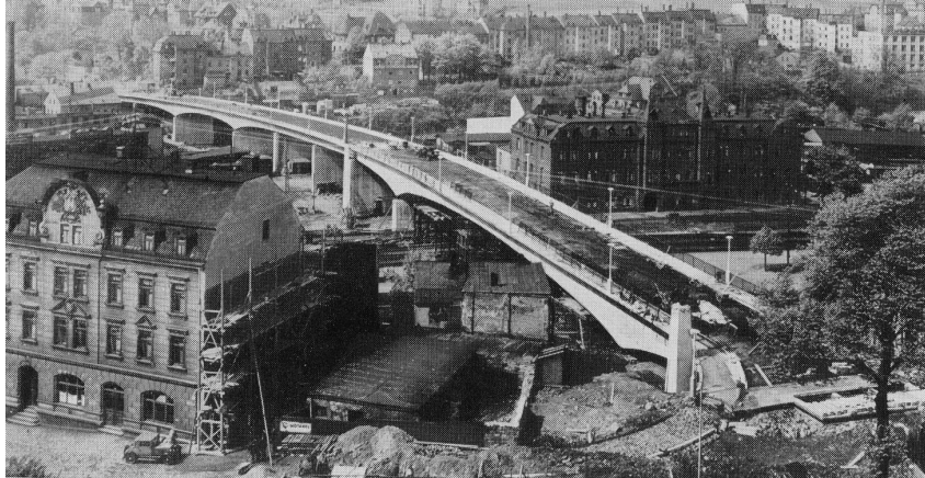
Abbildung 8: Erste Spannbetonbrücke in Deutschland 1935 [1]
