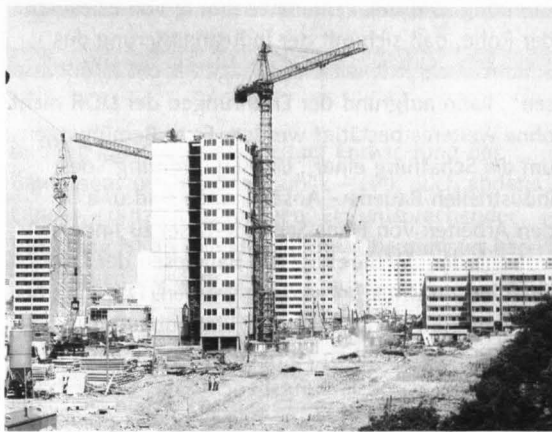
20l Bauplatz = Montageplatz
