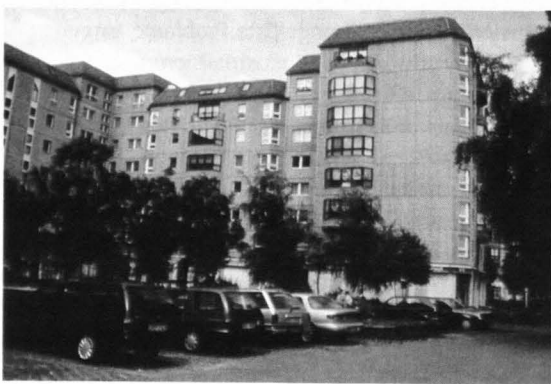
23| Berlin, Bebauung Wilhelmstraße in Großplattenbauweise; Baumeister Prof. Erhardt Giske, 80er Jahre
