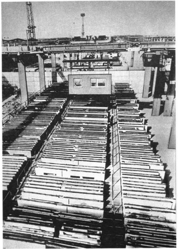
191 Massenproduktion standardisierter Bauelemente
