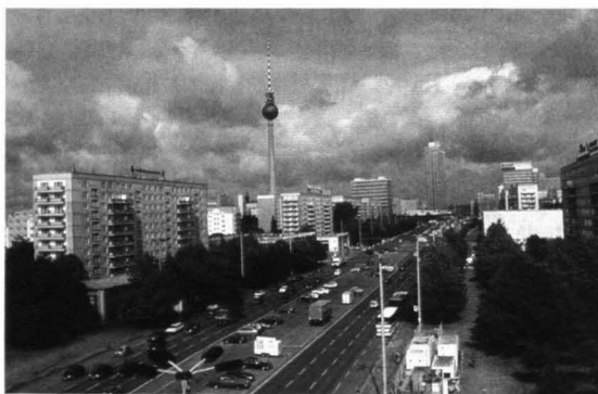
22| Berlin, Bebauung der Karl-Marx-Allee zwischen Strausberger Platz und Alexanderplatz ab 1958; Architekten: E. Collein, Dutschke, J. Kaiser, Fernsehturm 1965-69, Architekt G. Kosel
