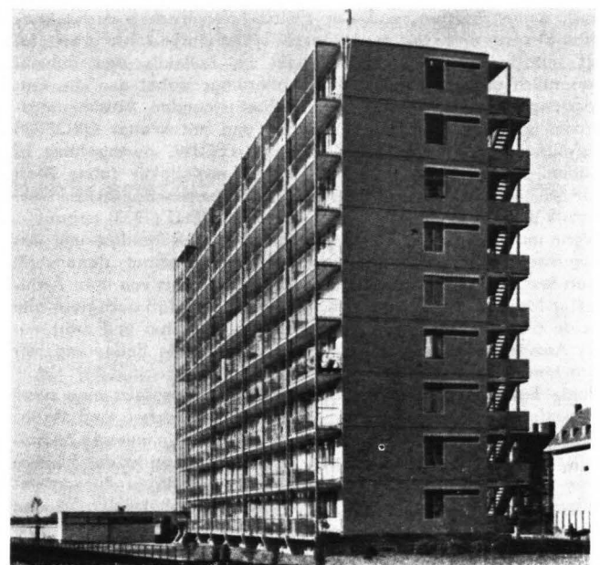
5 Rotterdam, Wohnhochhaus „Bergpolder Flat“. Willem van Tijen in Zusammenarbeit mit J. A. Brinkmann und L. C. van der Vlugt, 1934
