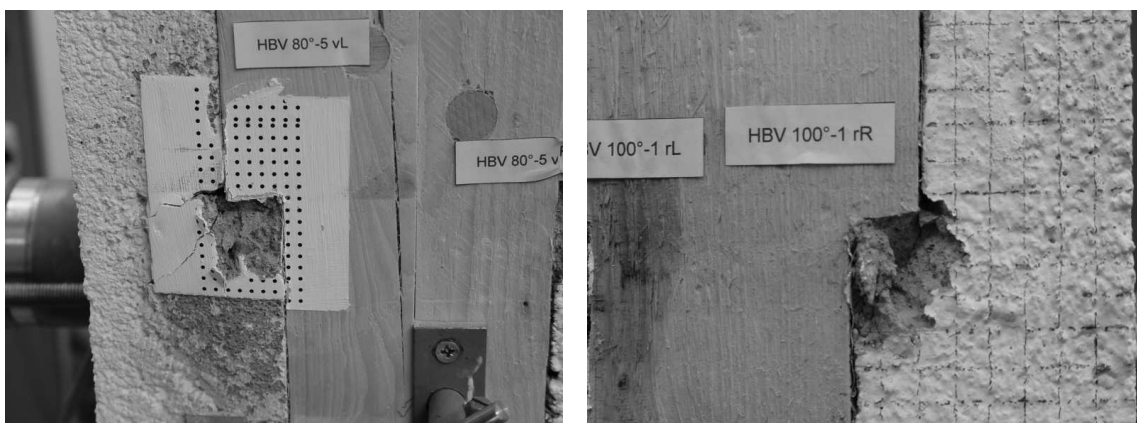
Abbildung 2.15: Typisches Bruchbild der Nutverbindungen, charakterisiert durch Betondruckversagen an den Kervenflanken
