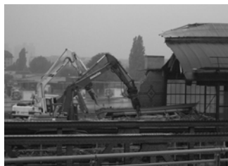
Abbildung 1: Umbau des Lehrter Bahnhofs
