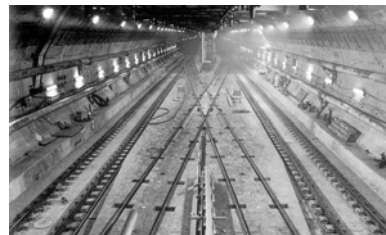
Abbildung 2: Bau des Eurotunnels
