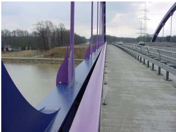
Abb. 3: Hänger mit Anschlüssen
