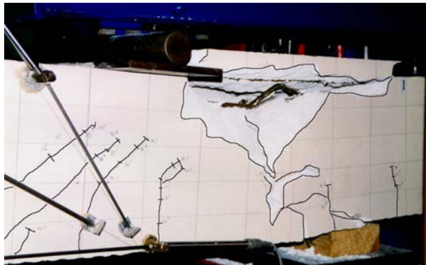
Abb. 6.1.3.6 Bruchbild des Versuchs balkens VI/3/13/ds_8_3 mit einem Verankerungstabdurchmesser 8mm
