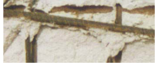
Abb. 6.1.1.5 Zerstörter Querkraftbereich des Versuchsbalkens VI/3/13/1A_1 (Bügelabstand s_w=5\text{cm} )
