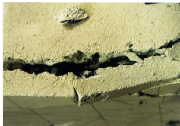
Abb. 6.1.1.4 Detail der Rissentwicklung an der Oberseite der Versuchsbalken bzw. der abgeplatzten Überdeckung von Versuchsbalken VI/3/13/1A_1
