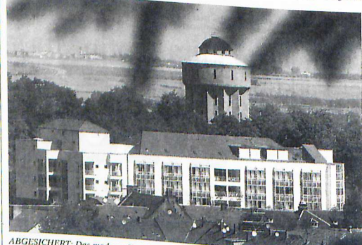
ABGESICHERT: Das moderne Kreisbrunnenhaus unterhalb des Arnberges garantiert eine umfassende medizinische Versorgung für Arnstädter und die Bewohner des Umlandes.
