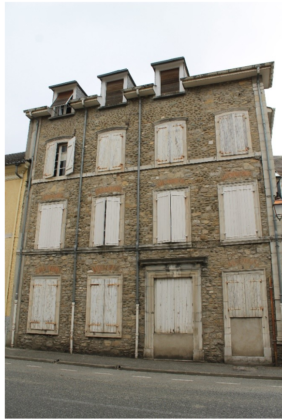
Abb. 56: Die ehemalige private Klinik des Chirurgen LAFITTE in der Rue Adoue 41 in Oloron, aufgenommen 2012. HANS SERELMAN wurde hier im Frühjahr 1944 an seiner Armfraktur operiert (Quelle: privat).
