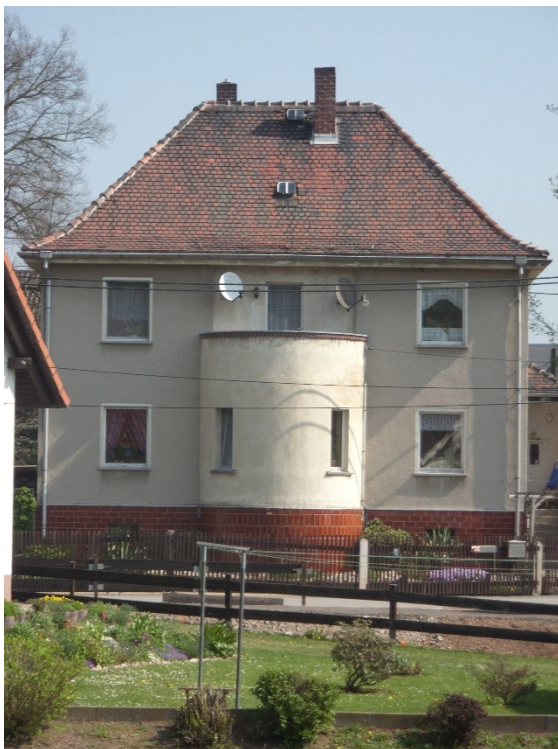
Abb. 16: Das Wohnhaus der SERELMANs, Niederlungwitz, Wehrstraße 7, heute Mühlenstraße 7 (Quelle: privat 2012).
