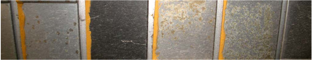
Abb. 95: Beispiel für korrodierte Chromoberflächen unter \text{CaCl}_2 Belastung im Feldtest
