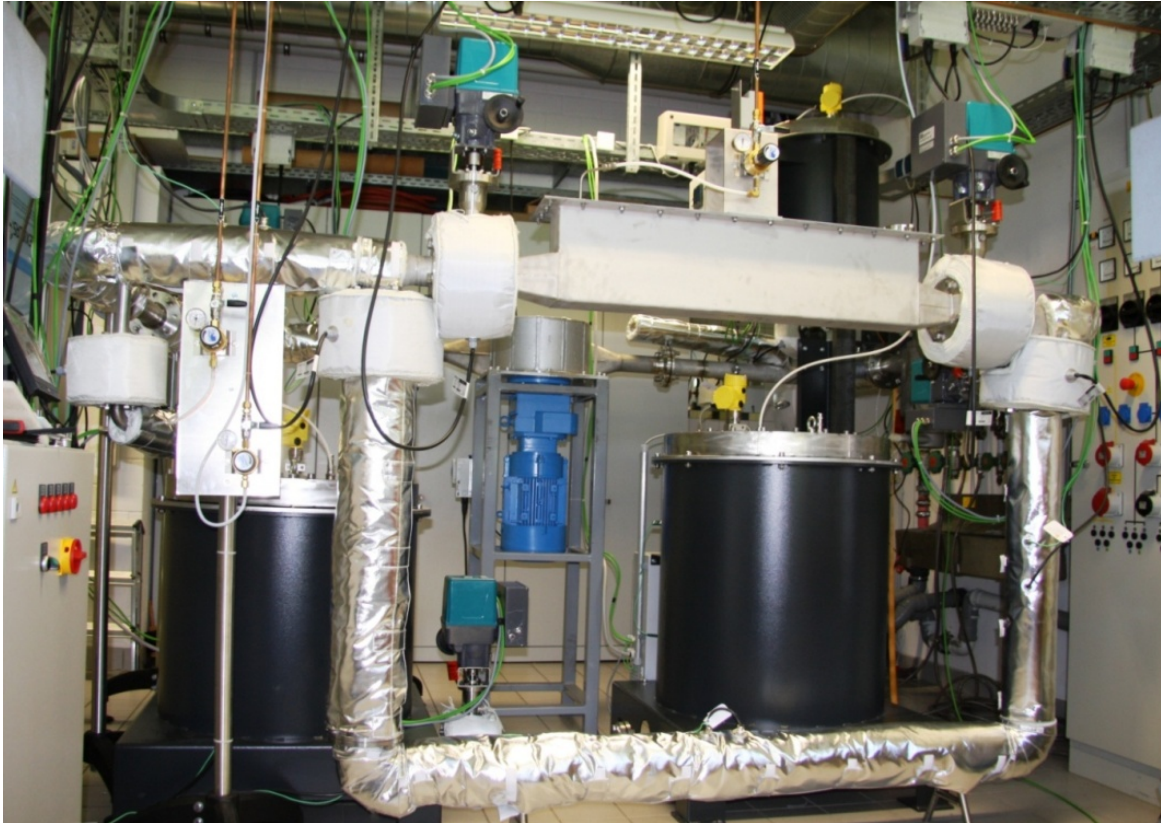
Abbildung 28: Tintelo gegen Ende des letzten Bauabschnittes. Im Vordergrund befinden sich die beiden Testsektionen, im Hintergrund sind die Öfen und die EM- Pumpe zu sehen.
