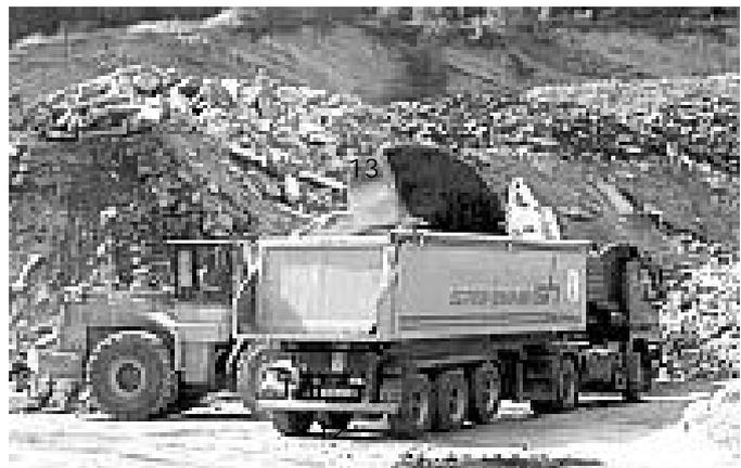
Bild 16 Abtransport von aufbereitetem Bauschutt
