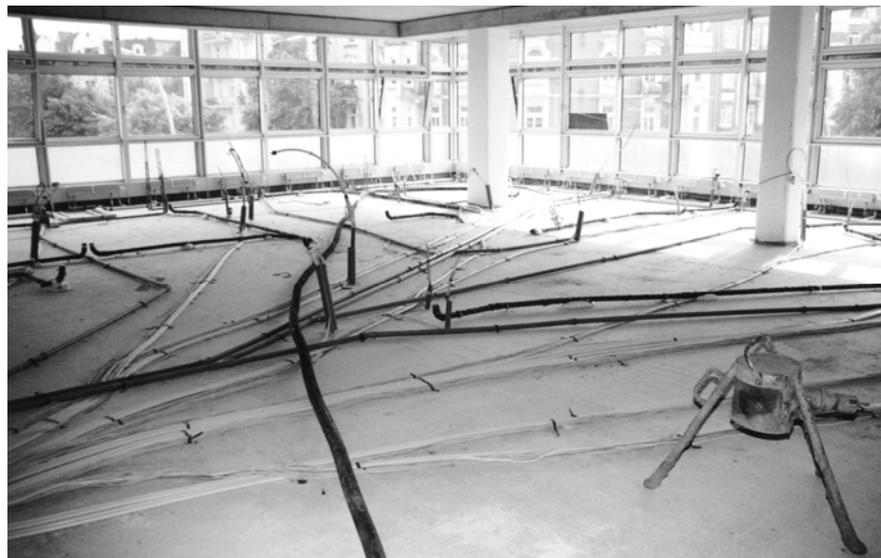
Bild 3 Rohrwirrwarr auf der Betonplatte [6]
