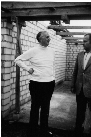
Rohbau in Ittenbach
