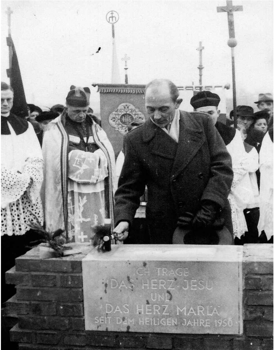
Abbildung 7: Pastor Struth, Domkapitular Janssen und Architekt Merl bei der Grundsteinlegung zur neuen Kirche am Tage der Weihnachtsvigil 1950.
