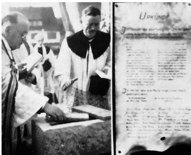
Abbildung 26: Die Grundsteinlegung durch Dechant Heinrich van der Griet und Pfarver Heinrich Struth am 23. September 1956.
