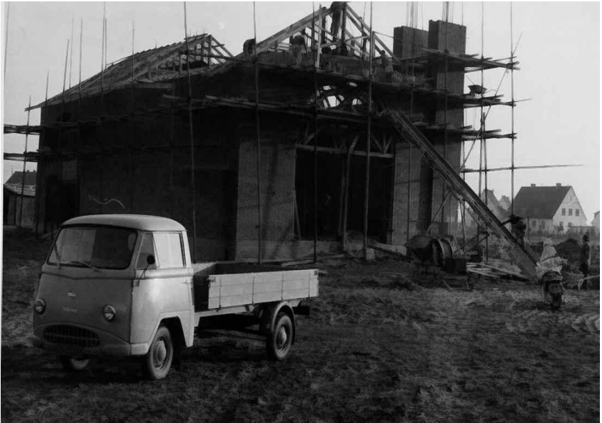
Abbildung 27: Die Herz-Mariä-Kirche im Rohbau.
