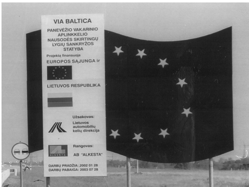
Abbildung 4: Ausbau der Straßeninfrastruktur – hier Ortsumgebung von Panevezys
