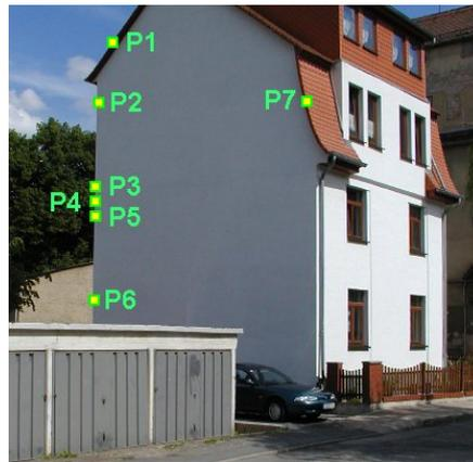
Abbildung 7.10: Nicht signalisierte Anzielung von Punkten an einer Hausfassade
