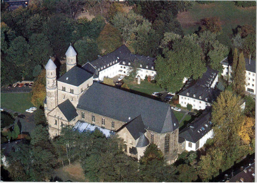
Abb. 6: Köln, St. Pantaleonskomplex mit Westwerk aus der Vogelperspektive
