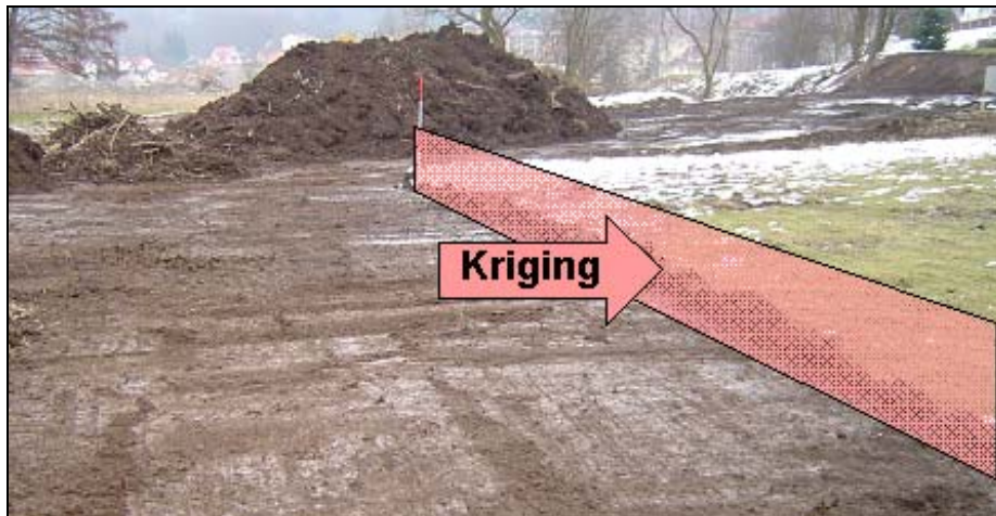
Abbildung 7-17 Praktische Umsetzung der Abgrenzung hochkontaminierter Überflutungsareale mittels Kriging: Abschieben des Oberbodens
