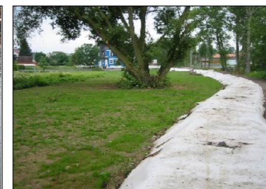
o) Der temporäre Schutzdamm, links bereits sanierte Auebereiche
