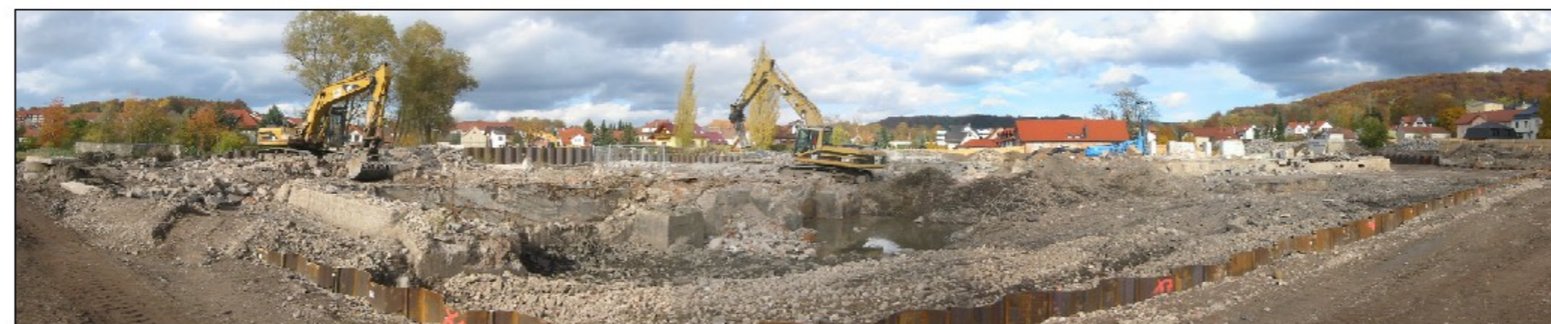
j) Tiefenentfrümmerung und Bodensanierung innerhalb der Spundwand (11/2004)
