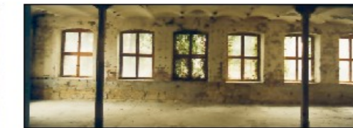
g) entkernte Fabrikhalle N83
