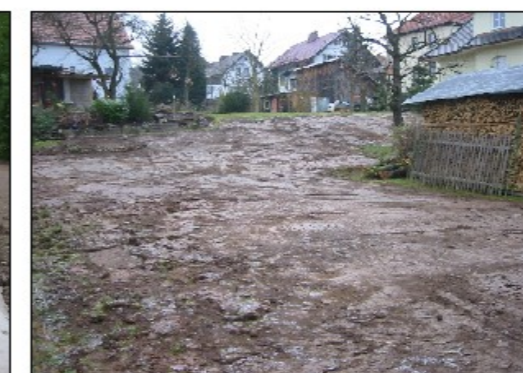
p) Bodensanierung im Wohngebiet
