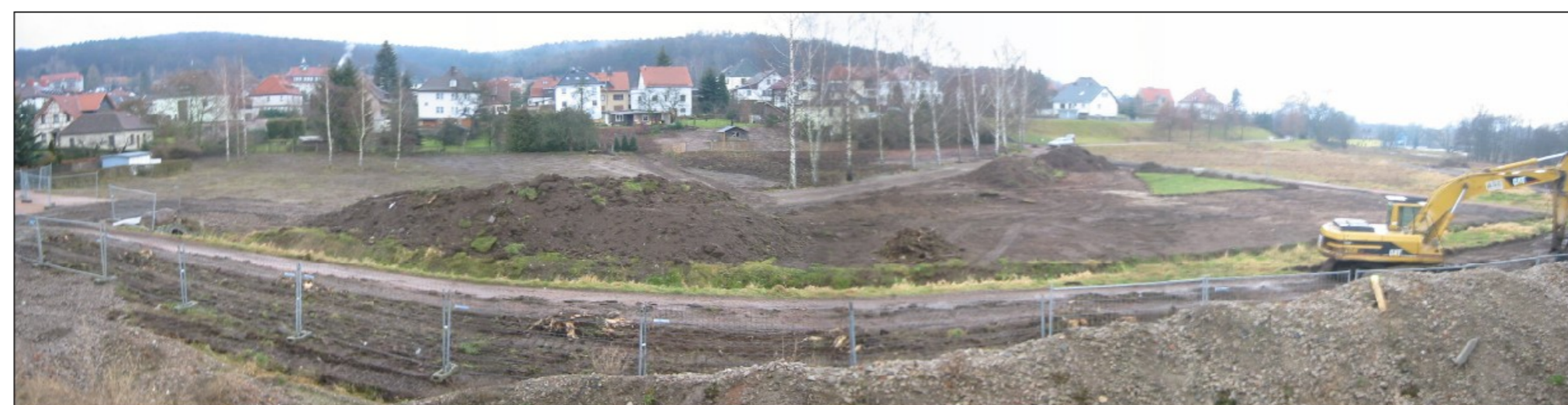
r) Bodensanierung in der Grumbachau
