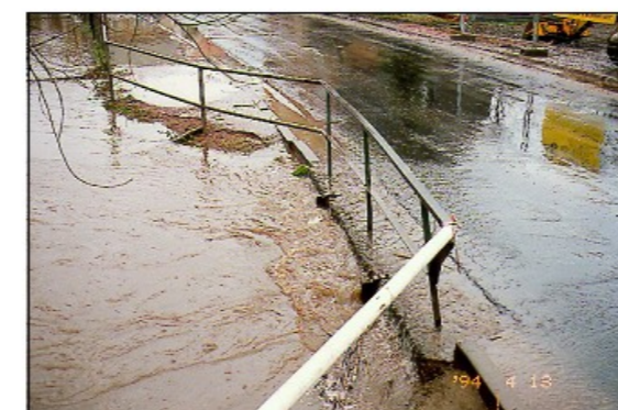
n) Überströmung der Grumbachbrücke
