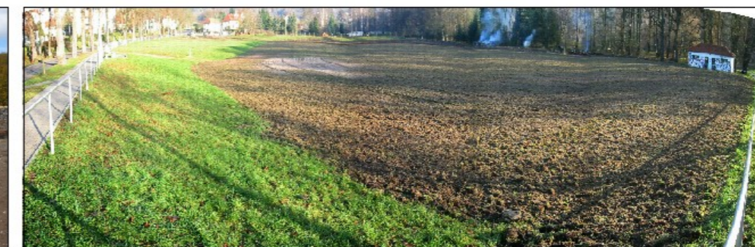
k) Sanierung des Sportplatzes
