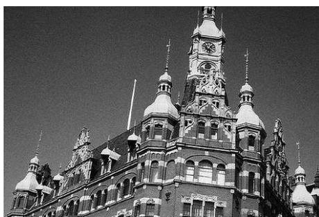
Die Dächer des Hauses sind aus Kupfer gefertigt worden. Infolge der Korrosion sind diese jetzt mit einer grünlichen Patina überzogen.
