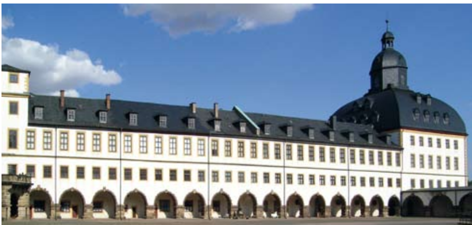
Sanierung auf Schloss Friedenstein: Im Ostflügel wird bald ein Fahrstuhl eingebaut, davon ist auch die Nutzung der Forschungsbibliothek betroffen.
