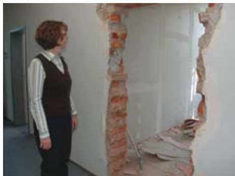
Neugierig: Während der Umbauarbeiten nahm Christina Schulz ihr neues Büro in Augenschein.
