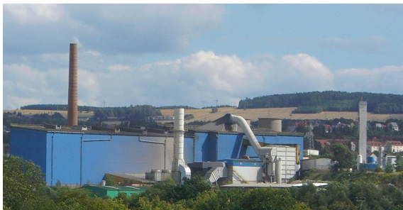
Abb. 3.1: Stahlwerk Thüringen: Elektrostahlwerk
