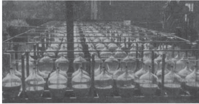
Abbildung 2.7: Anlage zur Herstellung von Ascaridol durch Sonnenbelichtung [63]
