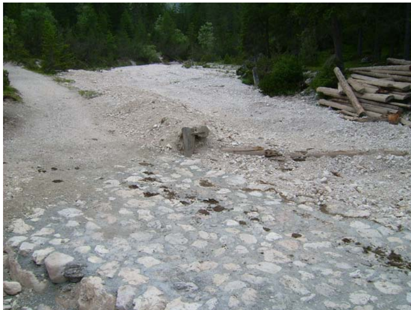
Abbildung 79: gemauerter Fahrweg über den Finsterbach ins Grünwaldtal (Foto: THIELEMANN 2007)
