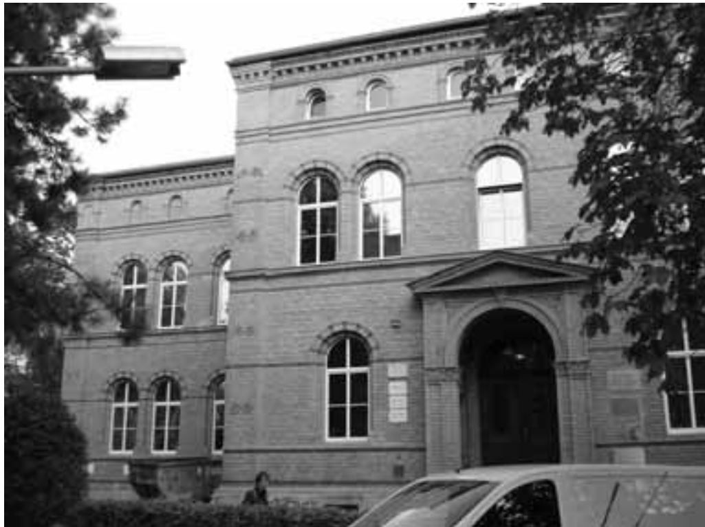
Südfrent mit Haupteingang
