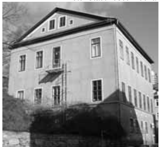
HELLFELDSches Haus, Südostseite
