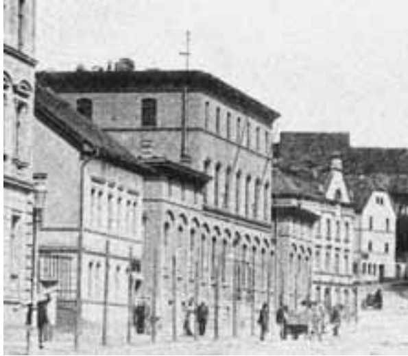
Der Neubau des Instituts
