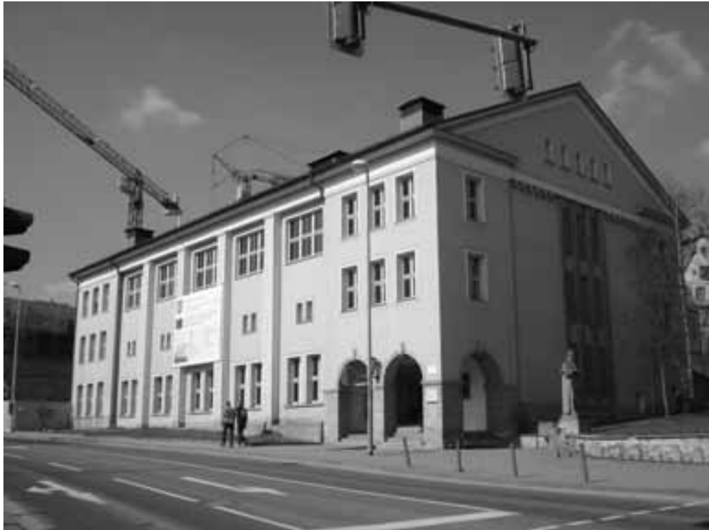
Südostecke mit Eingang
