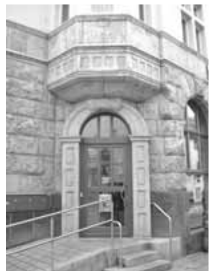
Eingang zu den Erdgeschossräumen in der Nordwestecke
