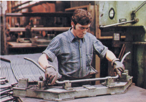
Bild 4.37: Prüfen der Formgenauigkeit eines Stabilisators
